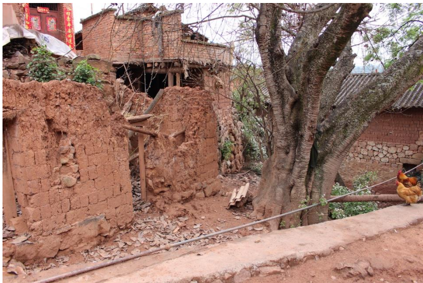
第一戶現有基礎以及屋前榕樹
